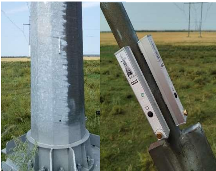
Установка датчиков на многогранной опоре
