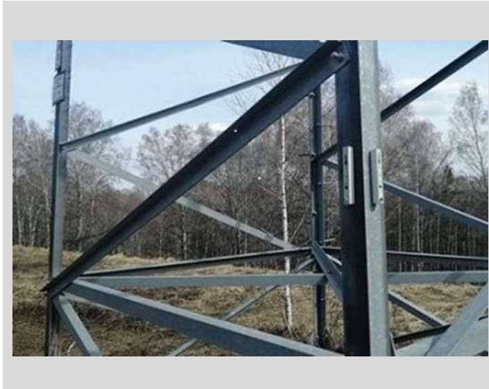
Установка датчиков на металлической опоре
