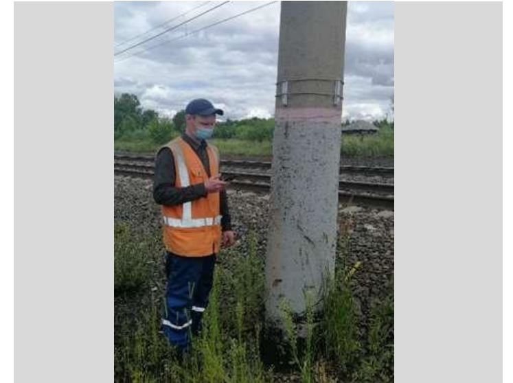
Установка датчиков на ж/б опоре
