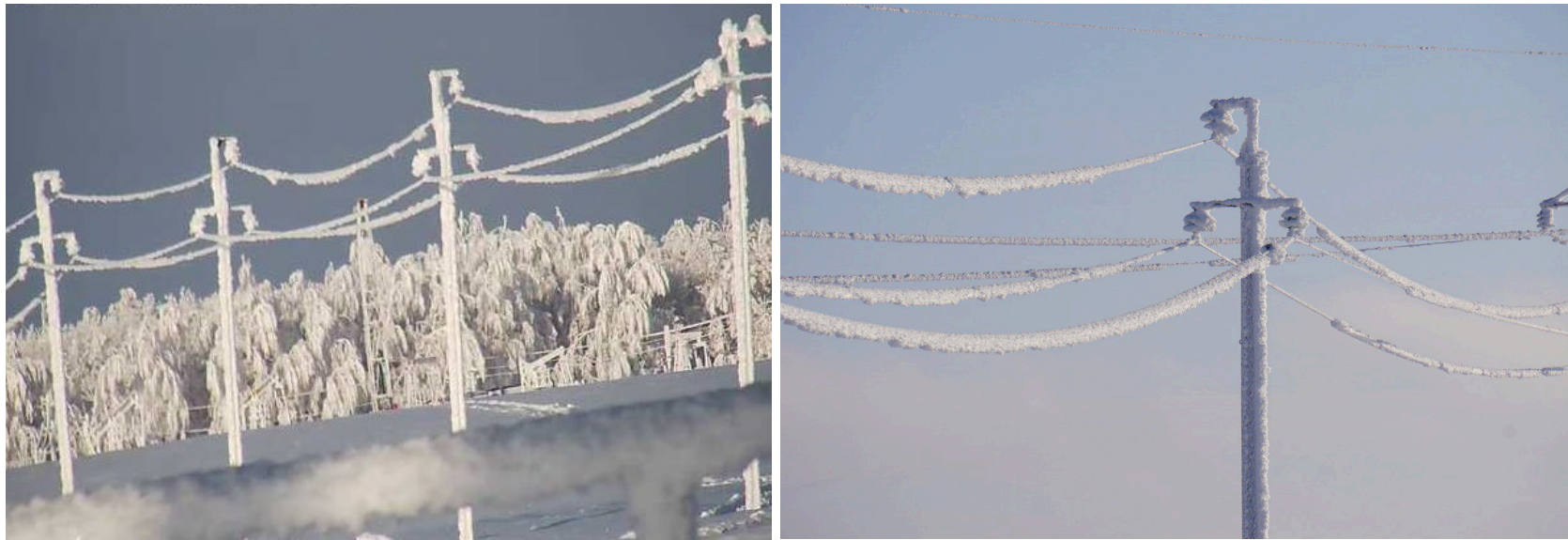
Гололедообразование на ЛЭП в ПАО «Татфнеть»
