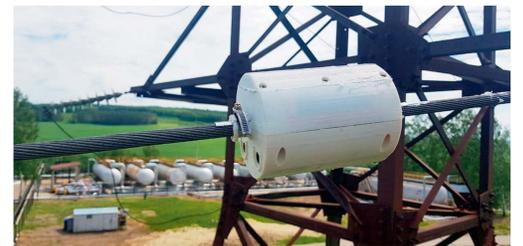
Установленные устройства на фазных проводах в ПАО «Татнефть» на ЛЭП 35 кВ
