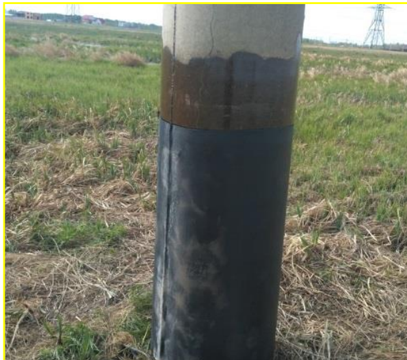
Ремонт жб стоек опор
