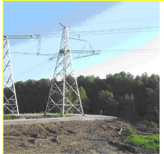
Защита оснований опор
