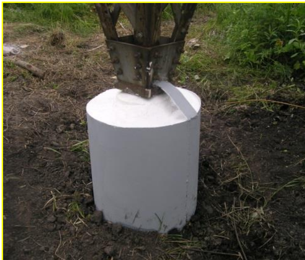
Протекторный ремонт фундамента
