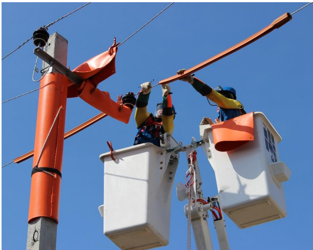
Метод работ под напряжением «Комбинированный»
