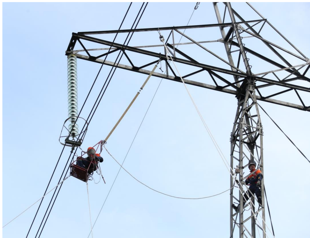
Метод работ под напряжением «На потенциале»
