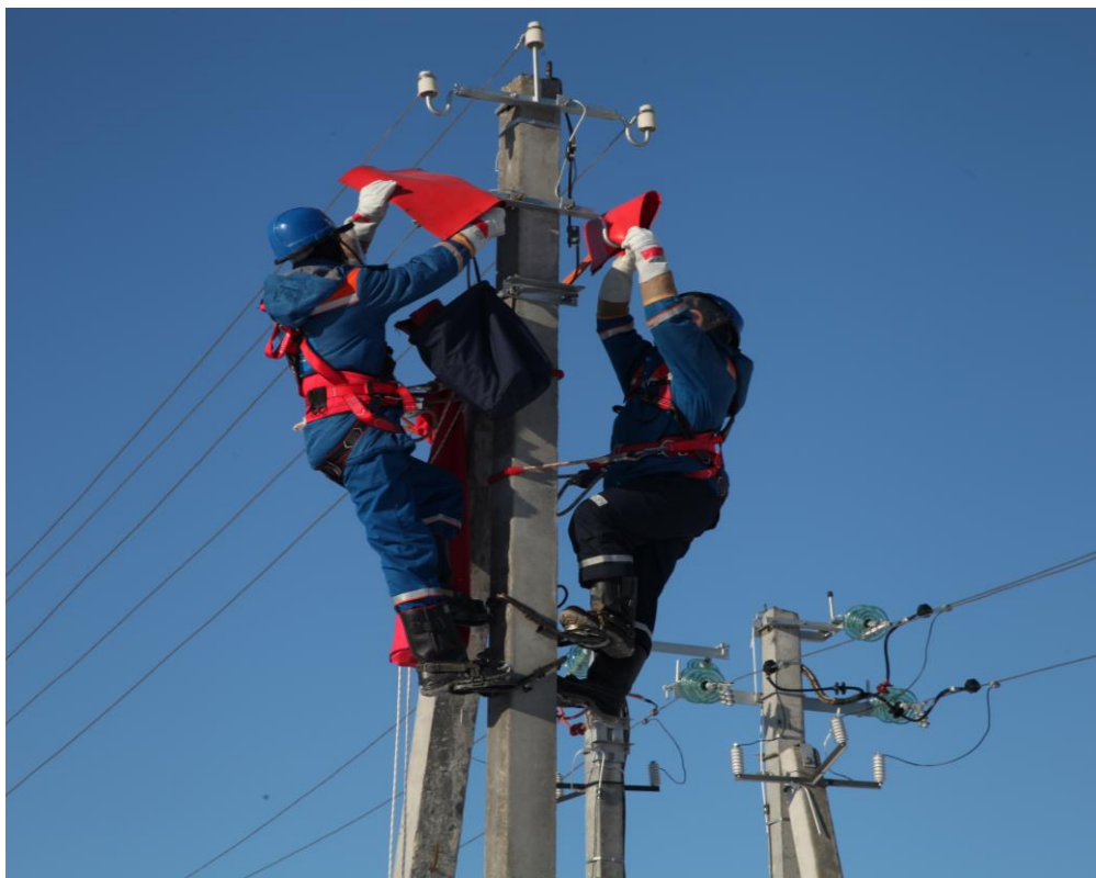
Метод работ под напряжением «В контакте»
