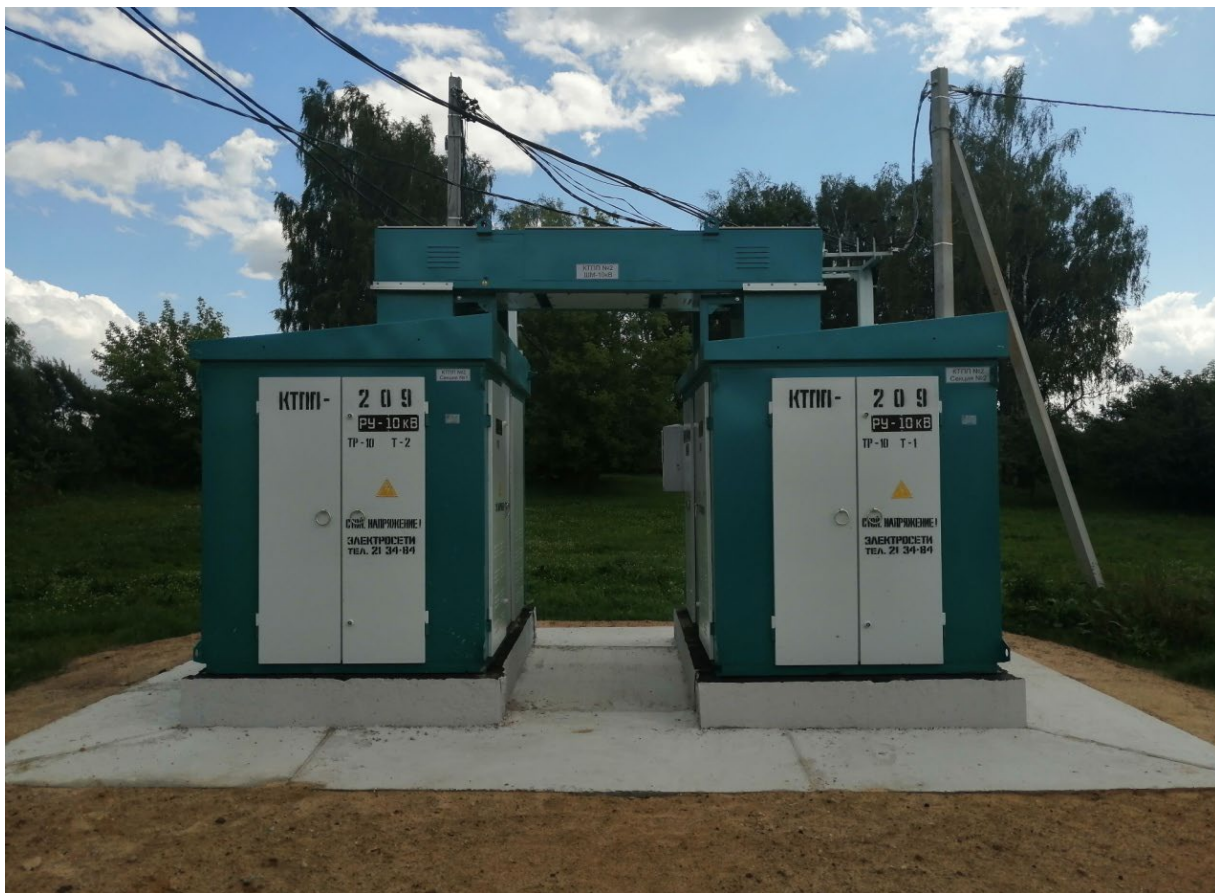
Двухтрансформаторная КТПП
