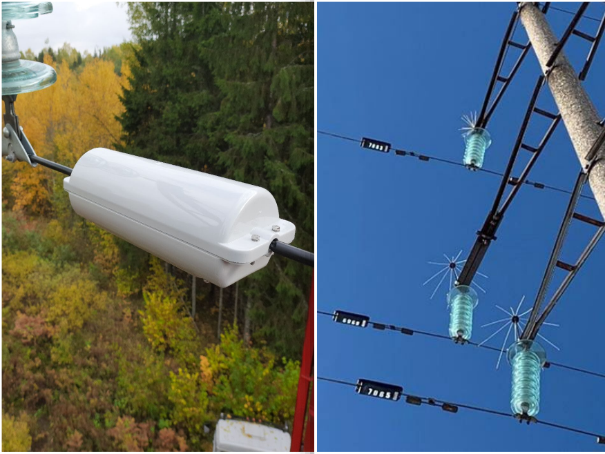
Установка модуля дистанционной диагностики на провод
