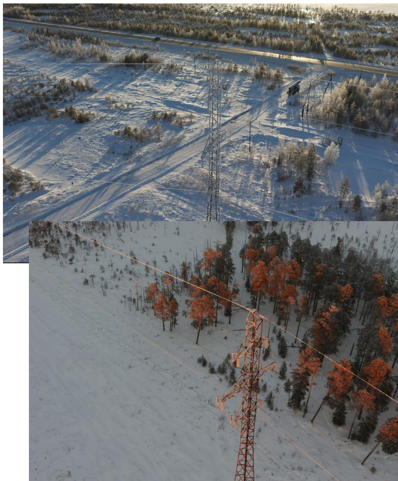
Коптер (высота – 40-50 м, съемка – под углом с точкой интереса на опоре)
